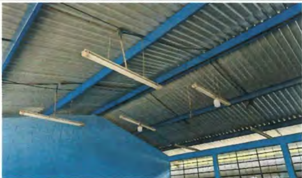
Foto 1: Cambio de tendido eléctrico y accesorios en todas las aulas.
