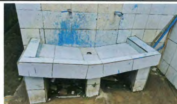
Foto 6: Sustitución de lavamanos.
