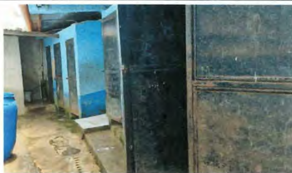
Foto 4: Sustitución de puertas de los servicios sanitarios.
